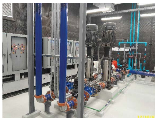
เครื่องสูบน้ำใช้ชั้นใต้ดิน และตู้ควบคุมการทำงาน
