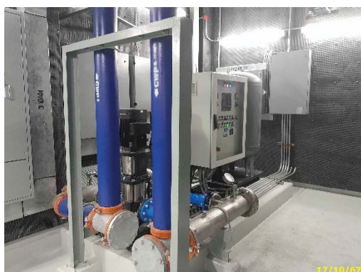
เครื่องสูบน้ำขึ้นห้องเครื่องลิฟต์ และตู้ควบคุมการทำงาน
