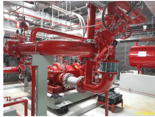
เครื่องสูบน้ำดับเพลิง High Zone และ Low Zone และท่อยื่น
