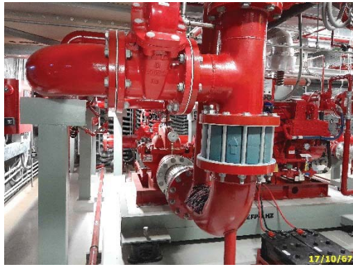
เครื่องสูบน้ำดับเพลิง High Zone และ Low Zone และท่อยื่น
